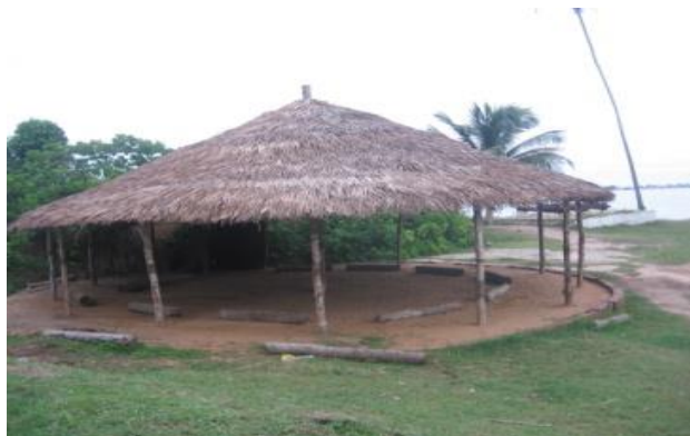
Fig. 6 – Oca construída na Aldeia Forte Fonte: Severina do Carmo
